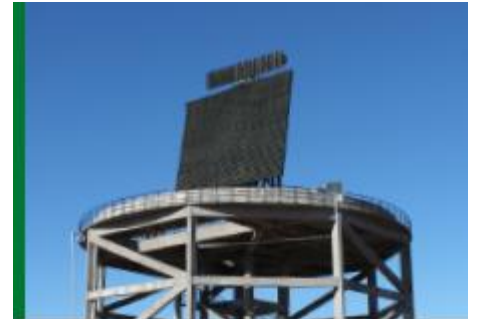
Instalación fija sobre torre
